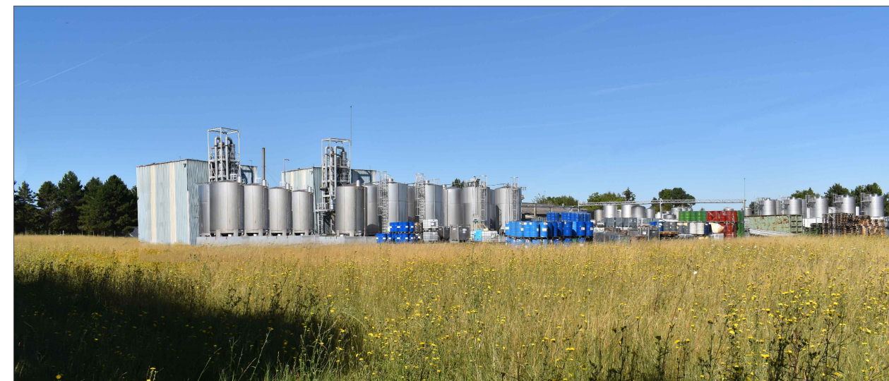
Projet : Bâtiment 4 (vue avec cuves)
